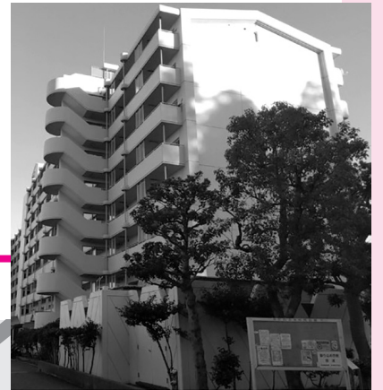
1号棟（昭和63年竣工、9階建て）
