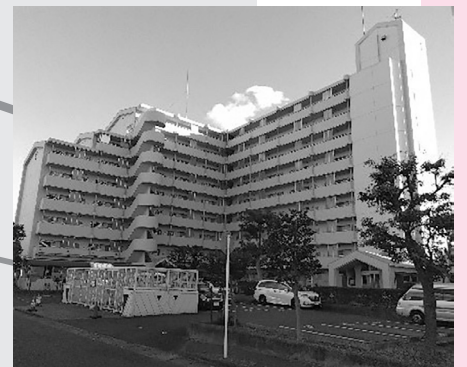
2号棟（昭和63年竣工、9階建て）
