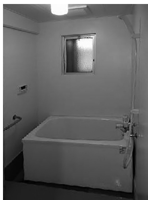
風呂設備 (給湯器が導入されています)
