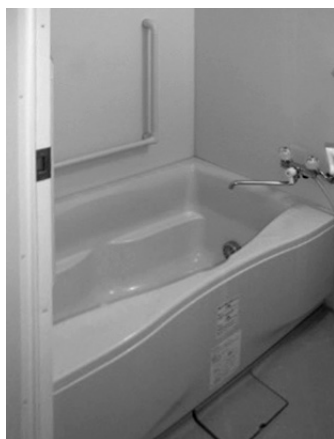
風呂設備 (給湯器が導入されています)
