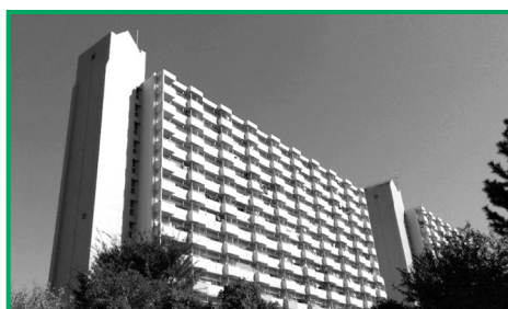
11号棟 (平成元年竣工、14階建て)
