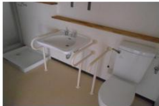
トイレ・洗面
